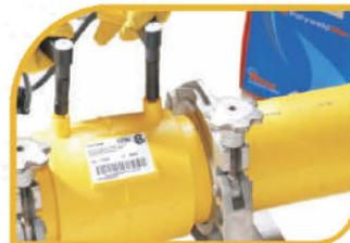
Las dos conexiones de enchufe del accesorio de electrofusión se giran hacia arriba (sin modificar por esto la posición axial del accesorio) y se unen a los adaptadores de conexión de los cables de soldar. Ubicar el cable de soldar de tal forma que su peso no desplace el accesorio.
